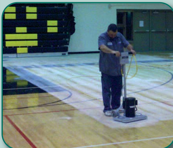
ОЧИСТКА ДЕРЕВЯННЫХ ПОЛОВ
